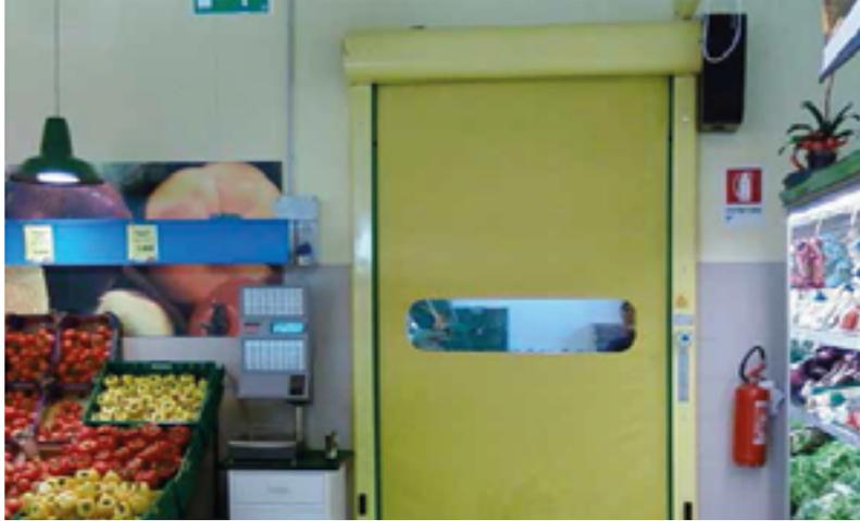
Este modelo de puerta autorreparable está concebida para su instalación en interior y exterior, con resistencias al viento hasta Clase 4 (hasta 160 km/h) y velocidad hasta 2,5 m/sg, en función de medidas.
